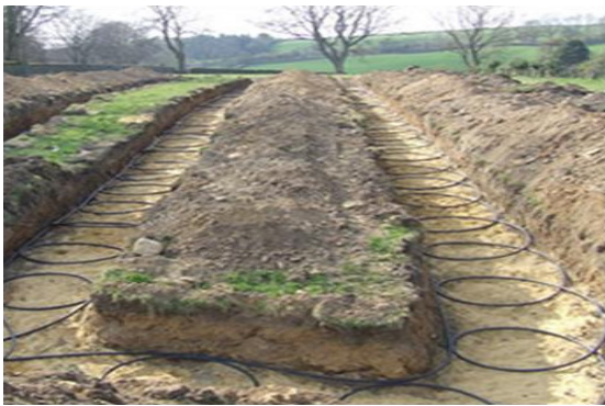
Vodoravni kolektor ( \approx 0,8 - 3,2 \text{ kW} / 100 \text{ m}^2 ). http://ingramswaterandair.com
